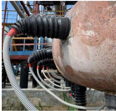
Рис.10. Монтаж УЗ возбудителей колебаний
