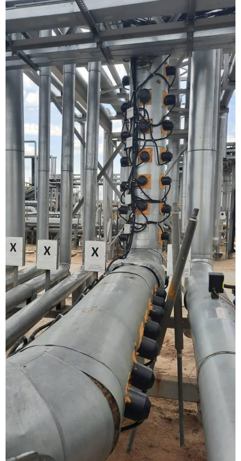
Рис.11. Монтаж УЗ возбудителей колебаний
